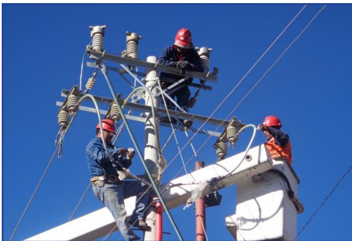
Proceso de instalación de una red de transporte de energía. Foto: Archivo
