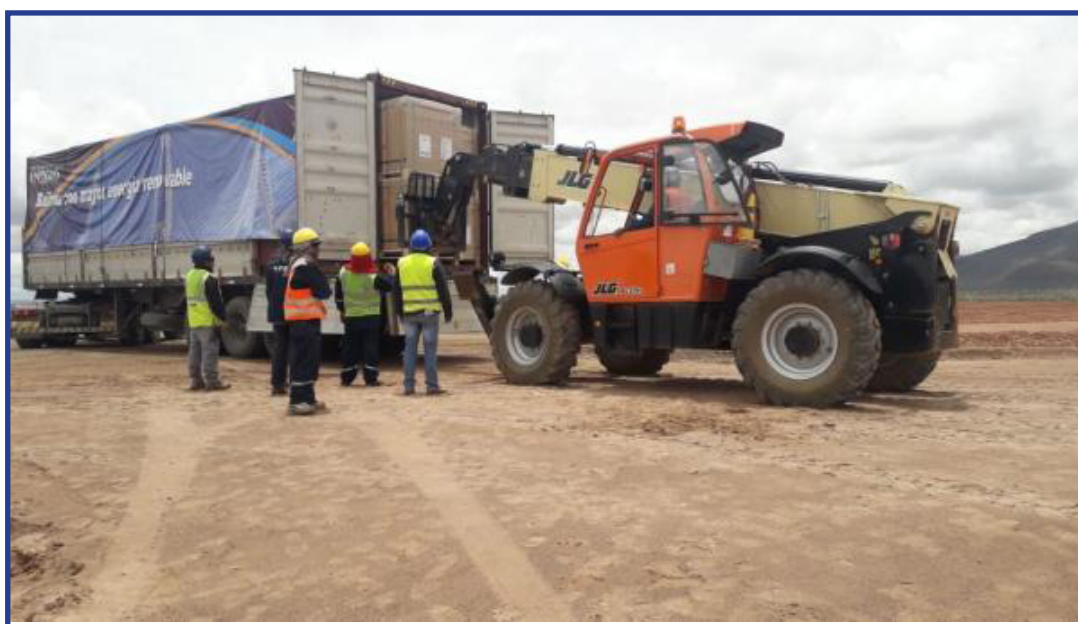
Un camión cargado de paneles fotovoltaicos para la planta solar de Oruro. Foto: ENDE
